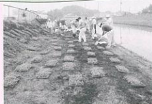
グランドカバーの定植作業（高石幹線排水路）
