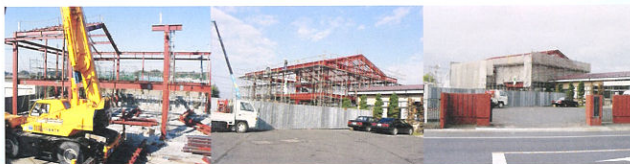
建設が進む中央管理センター
