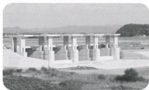
工事途中の長沼水門
