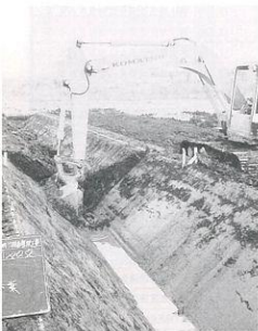
県は迫南部地区排水路工
