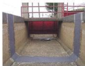
用水路目地補修 (Vシート工法)
