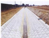
排水路護岸補修 (連結平板ブロック)
