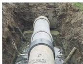
管水路補修 (HP新設・Yジョイント接続)
