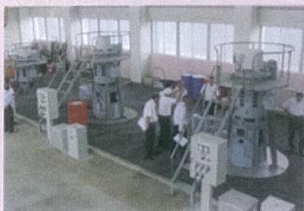
管内視察：南方揚水機場
