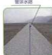
排水路を管路化
