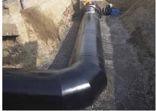
〈新管布設完了〉
