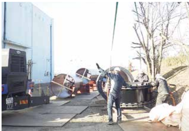
〈布設鋼管運搬状況〉
